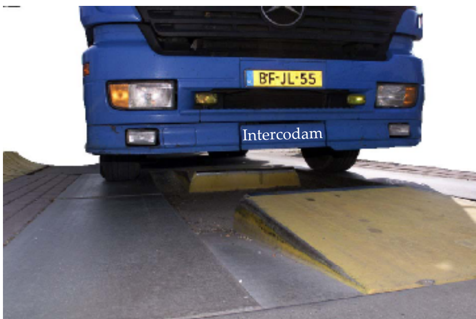
Praktijk situatie Bussluis oplossing
